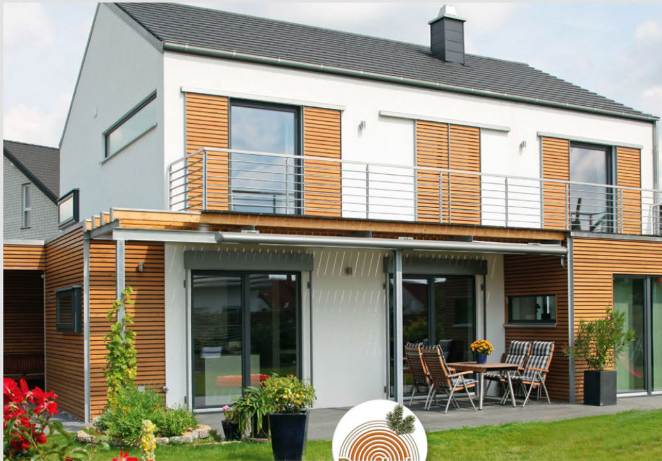
Rhombusprofil aus Douglasie glatt gehobelt, roh
